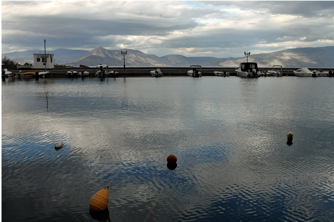
Σχήμα 3.2: Άποψη εσωτερικά της εξεταζόμενης λιμενολεκάνης
