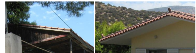
Αντιπαράθεση κεραμικών στεγών. Αριστερά στέγη με ξύλινο υπόβαθρο, εύφλεκτη. Δεξιά, τσιμεντένια, δεν αναφλέγεται. Και στις δύο περιπτώσεις η βλάστηση ακουμπά στις στέγες, γεγονός που αυξάνει τον κίνδυνο από πυρκαγιά.
