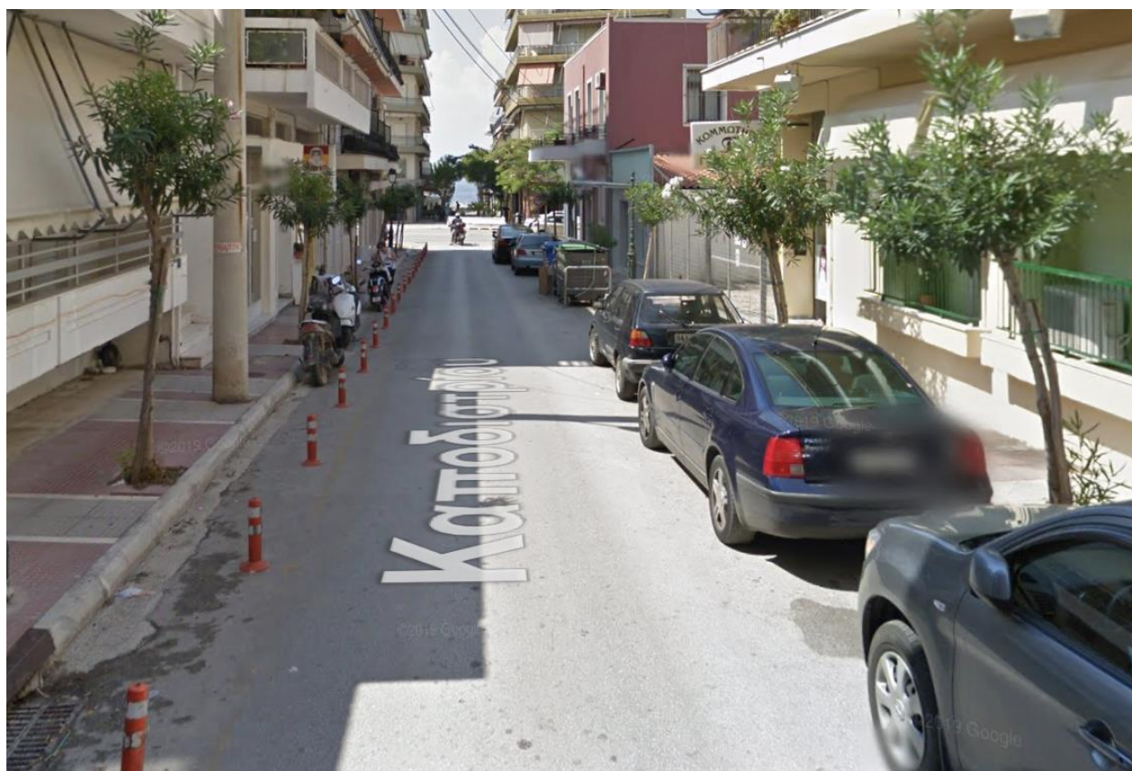
Εικόνα 18: Υφιστάμενη Κατάσταση οδού Καποδιστρίου (Πηγή: Google Maps)
